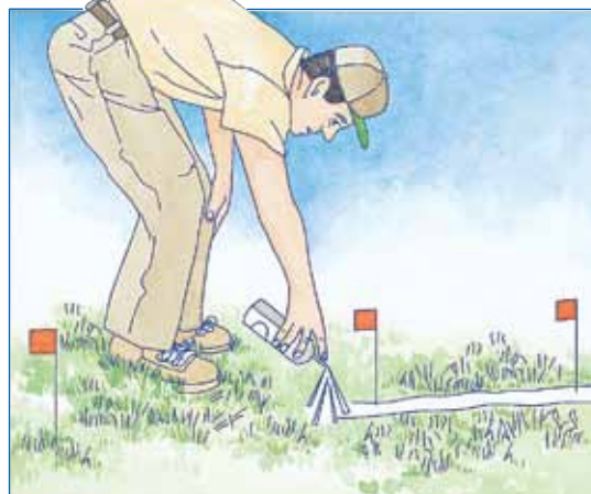
Pirms tranšejas rakšanas izmantojiet mazus karodziņus un aerosol krāsu, lai parādītu, kur atradīsies laistīšanas sistēma
