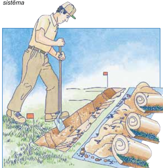
Vispirms izklājiet plēvi un noņemiet velēnu, pēc tam izrociet tranšejas 25-30 cm dziļumā galvenajai līnijai, 15 cm dziļumā šķērslīnijai.
